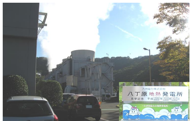
写真 八丁原地熱発電所・冷却塔(看板は合成)
