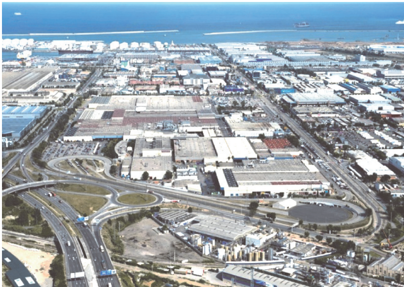
工場外観(空撮)
