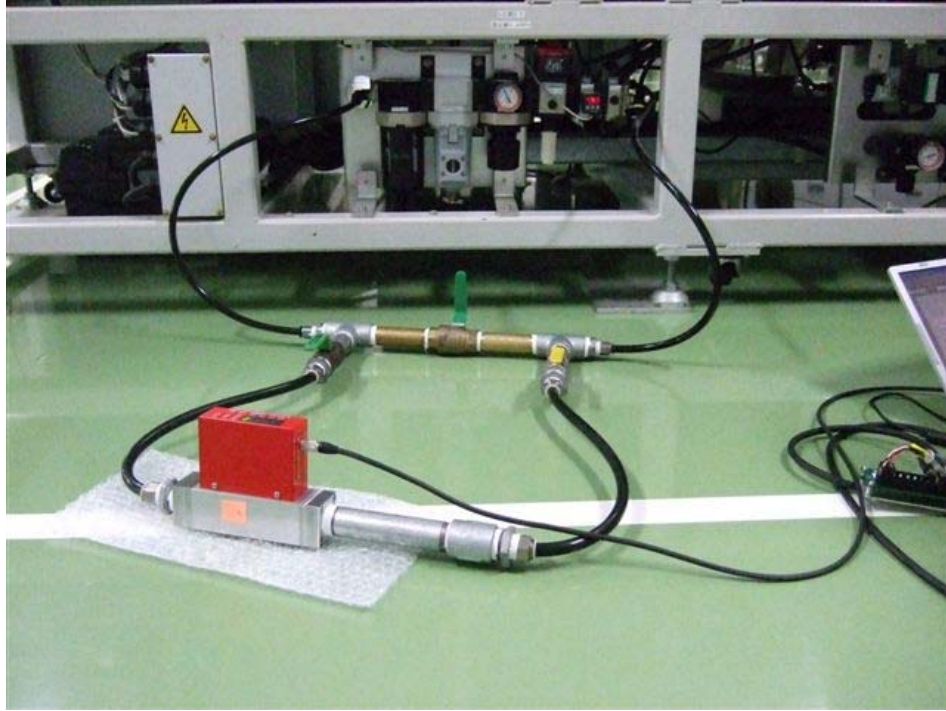
写真 1.1.2 エアパワーメータ接続状態
