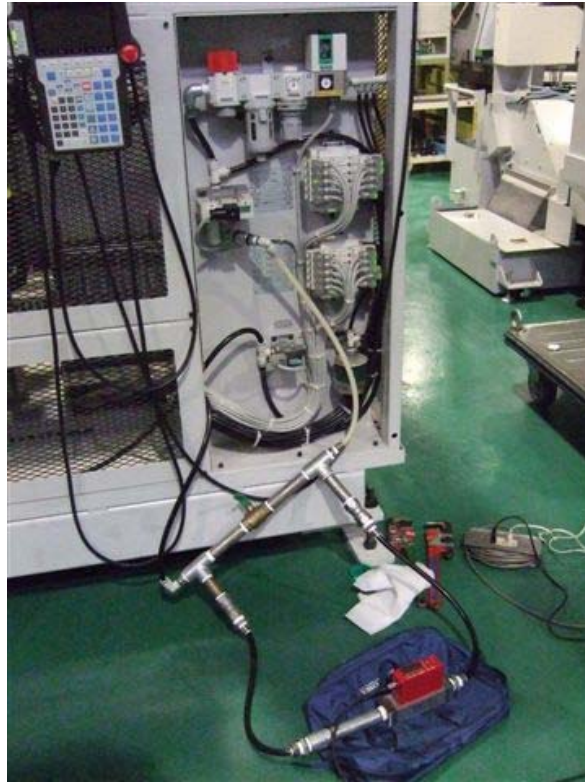
写真 1.1.3 エアパワー接続状態
