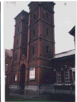
ポンプハウス
