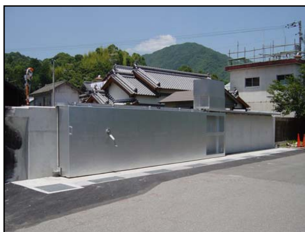
高潮対策自動ゲート
