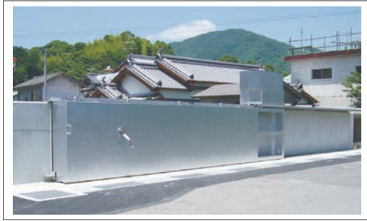
図 3.4.4 高潮対策自動ゲートの例
