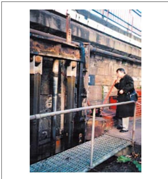
図 12 水圧シリンダにより駆動される水門
