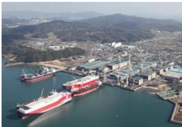
(株)新来島どつく・大西工場（全景）
